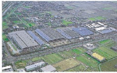
⑤中部工場 生産商品：事業用建築 静岡県袋井市
