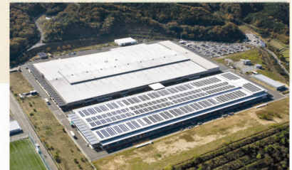
⑨岡山工場 生産商品：戸建住宅、集合住宅 岡山県赤磐市
