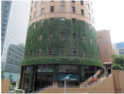
【1階から6階の壁面緑化のようす】
