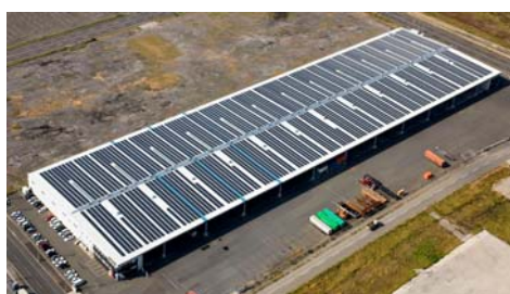
ひびき国際物流センター メガソーラー
