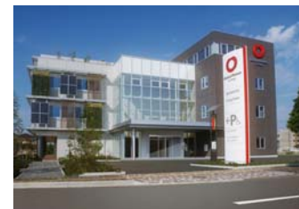
環境配慮型オフィス「大和ハウス岐阜ビル」
