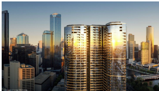
【「メルボルン クォーター ウェスト プロジェクト」外観イメージ】
