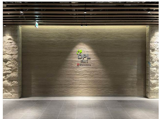
【メインエントランス（塗り版築）】
