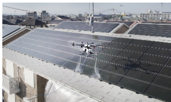
【屋根部洗浄の様子】
