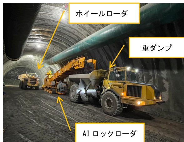
写真2 自動ズリ積み込み施工
