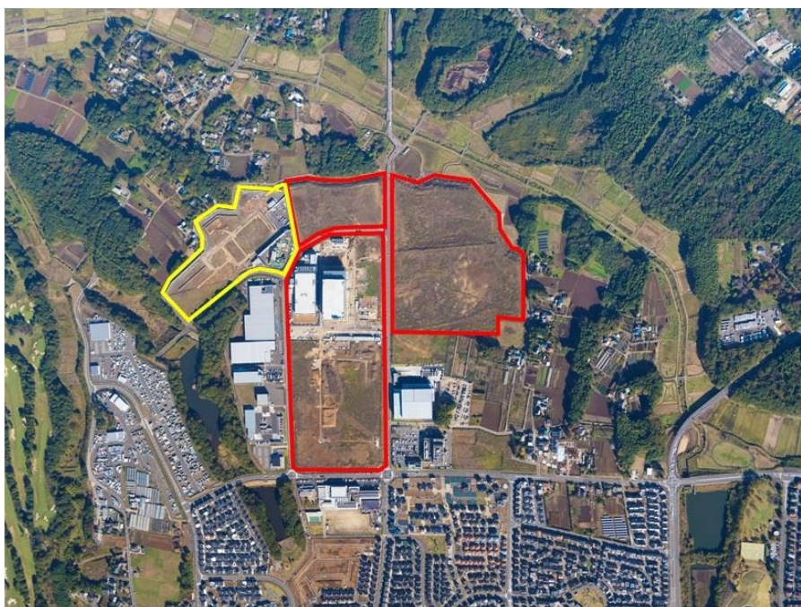
「DPDC 印西パーク」空撮（2021年11月撮影） （赤色枠：「DPDC 印西パーク」、黄色枠：「変電所」）
