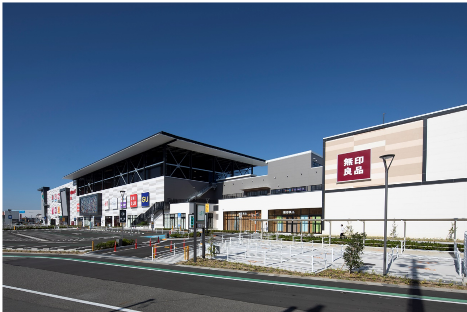
商業施設「iias（イーアス）春日井」外観写真
