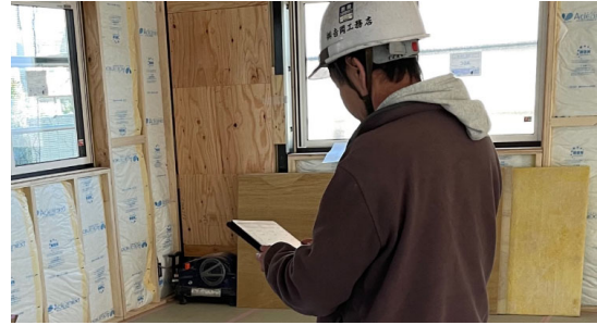
作業員がタブレットを通じて確認しているようす
