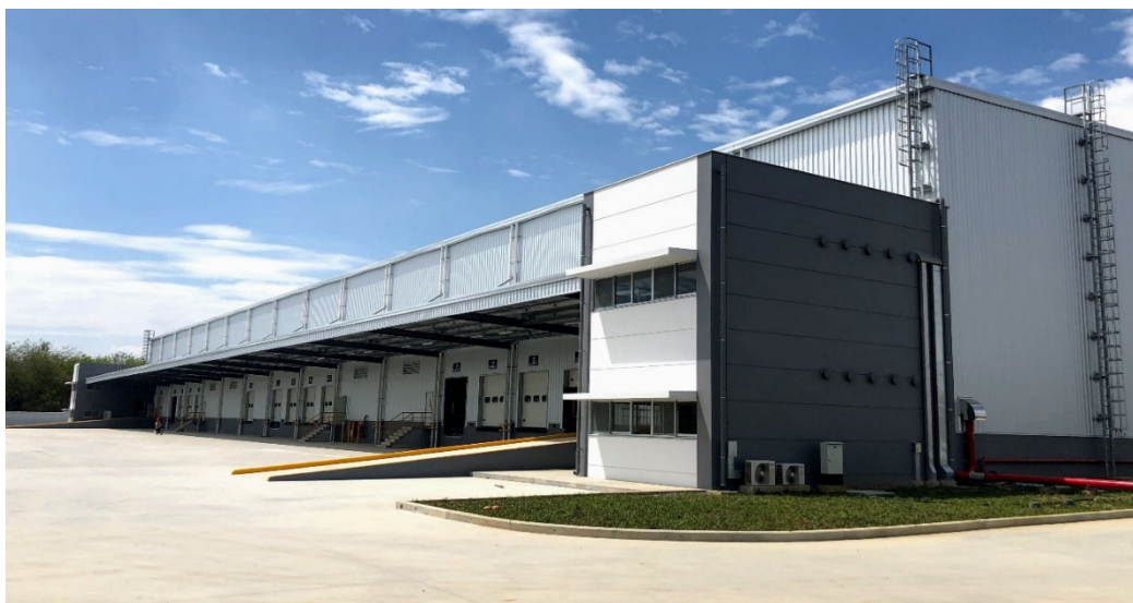
【ベトナムでの物流拠点「ロックアンビンソンロジスティクスセンター」】
