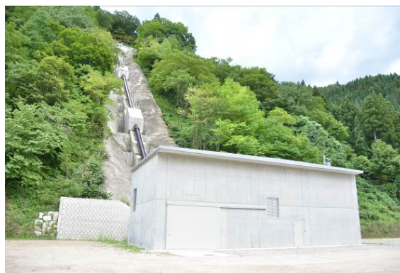
【菅沼第二水力発電所】
