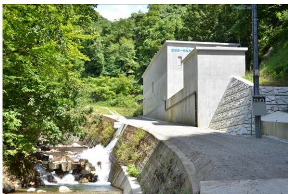
【菅沼第一水力発電所】
