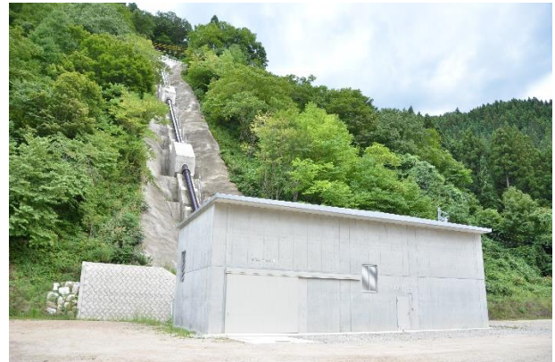
【菅沼第二水力発電所】
