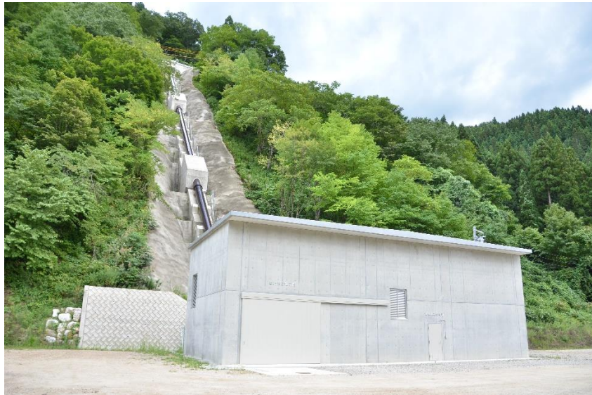
【菅沼第二水力発電所】
