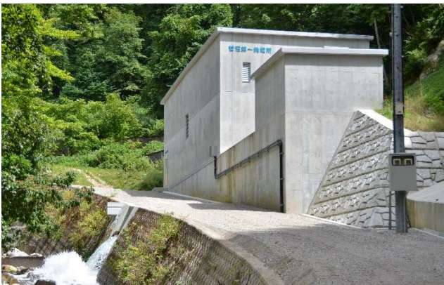
【菅沼第一水力発電所】
