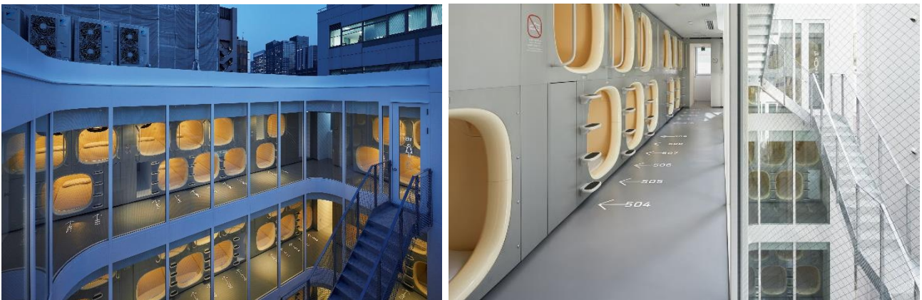
『9h(ナインアワーズ)竹橋』2~8階まで整然と積まれた129ユニットのカプセル
