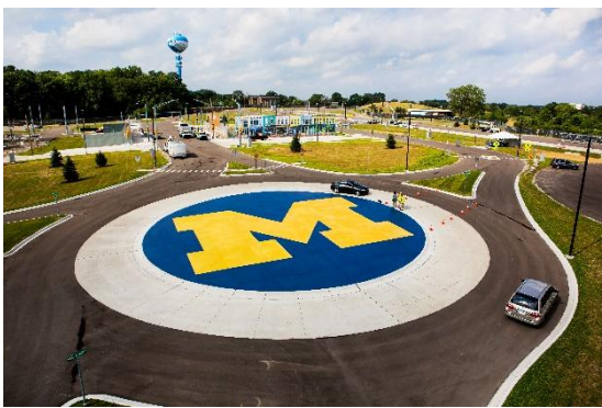
施設内に再現されたラウンドアバウト
