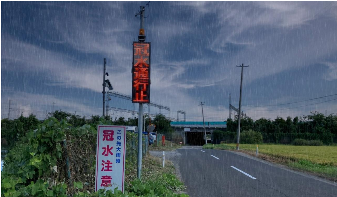
■宮城県利府町の町道に設置された冠水通知型LED表示機システムと、従来の注意喚起看板 ※雨天時のイメージ写真 (奥に見えるのがアンダーパス部)
