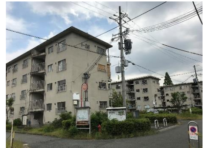
△金岡東・金岡東B団地(現況)
