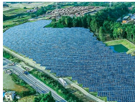
リエネ会津太陽光発電所
