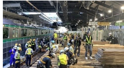
渋谷駅線路切換工事
