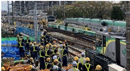
高尾駅線路切換工事
