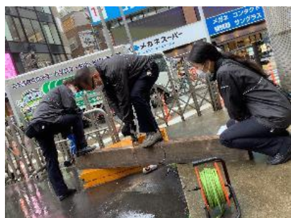
▲マクラギを切断・塗装処理
