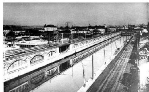
【完成当初の煉瓦アーチ高架橋】
