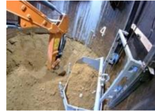
Shinso-MaN 工法（機械式深礎工法）
