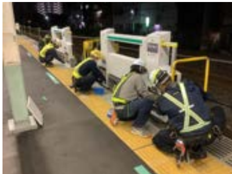
ホームドア工事
