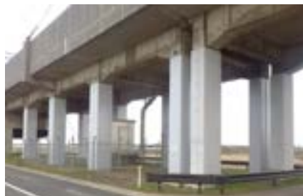
高架橋柱耐震補強
