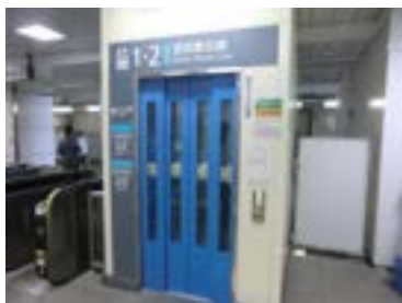
エレベーター
