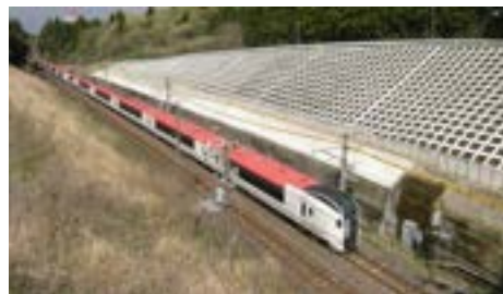
切取りの面工（吹付砕工）
