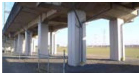
大規模地震対策（新幹線高架橋柱）
