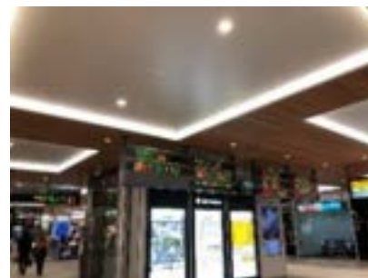
照明設備のLED化
