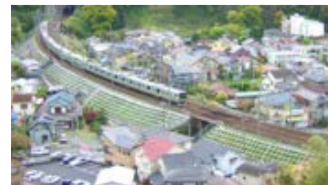
盛土のり面工（吹付砕工）
