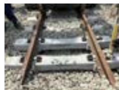
軌道構造強化 (弾性PC化)
