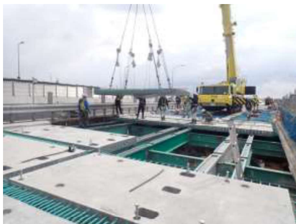
大規模更新状況(神田高架橋 架け替え)
