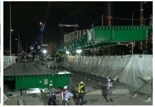
鋼床版・鋼桁
