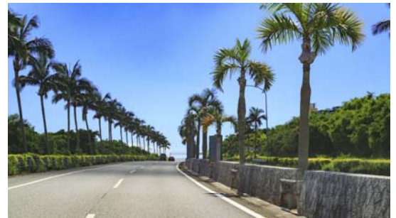
現在の沖縄自動車道
