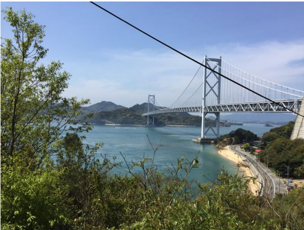
因島大橋：因島と向島を結ぶ吊り橋
