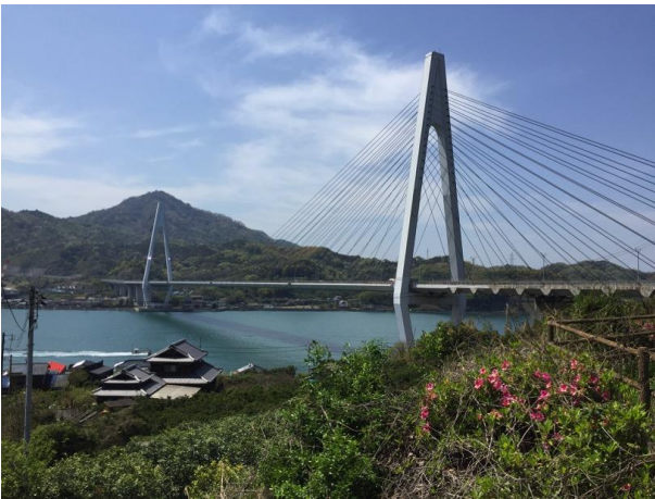
生口橋：因島と生口島を結ぶ美しい国内第4位の斜張橋
