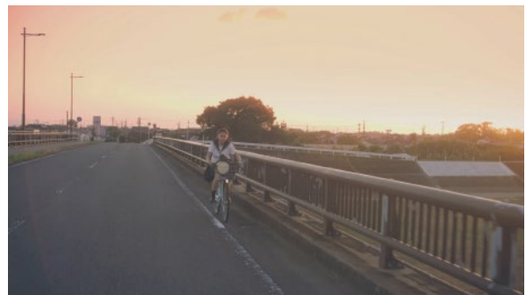
恒久橋 (大分県中津市)
