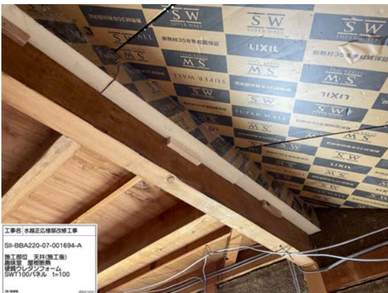
天井の吹き込み断熱に加えて屋根部など、隅々まで断熱パネルで性能強化。
