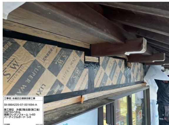
築40年を超える土壁に外断熱を施し、断熱リフォーム工法で気密性もアップ。 ※土壁の場合は外張りの断熱材を固定するための間柱の追加が必要になります。
