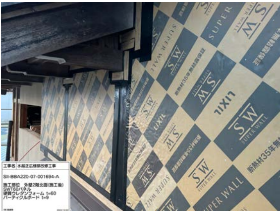
築40年を超える土壁に外断熱を施し、断熱リフォーム工法で気密性もアップ。 ※土壁の場合は外張りの断熱材を固定するための間柱の追加が必要になります。
