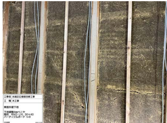
築40年を超える土壁に外断熱を施し、断熱リフォーム工法で気密性もアップ。 ※土壁の場合は外張りの断熱材を固定するための間柱の追加が必要になります。
