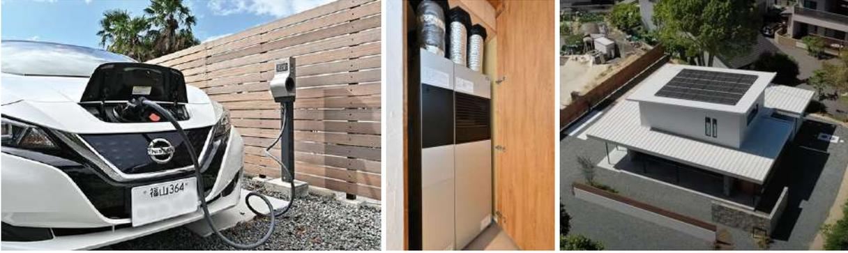
持続可能な社会に貢献できる暮らしを目指して、太陽光発電システム、計画換気と冷暖房を兼ね備えた全館空調「エコエアFine」、電気自動車（EV）やプラグインハイブリッド車（PHEV）のバッテリーに貯めている電力を自宅で使えるようにするV2Hといった最新の設備を採用している。
