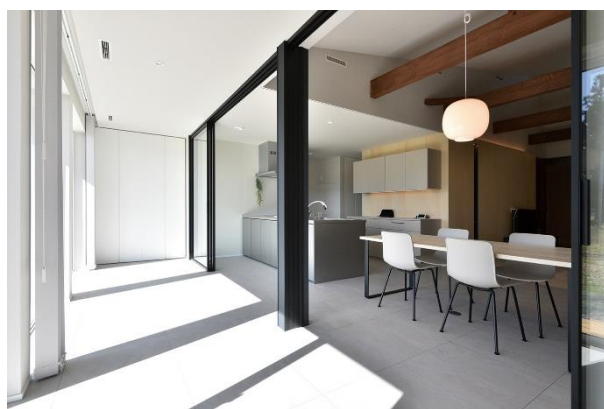
リノベ前、和室の広縁だった部分を活かして、ガラスで 2 重に覆ったダブルスキン構造に。空気の層をつくることにより、空調負荷を低減する効果も。
