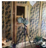
住宅の構造体と開口部の工事が完了した段階で気密測定を実施。新築住宅と比較しても高水準なC値0.19であることを確認。
