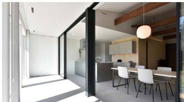
リノベ前、和室の広縁だった部分を活かして、ガラスで2重に覆ったダブルスキン構造に。空気層をつくることにより、空調負荷を低減する効果も。
