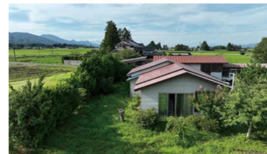
自然豊かな花巻市大瀬川に建つ築50数年の平屋。主を亡くし、庭も荒れてまわりから取り残されてしまった空き家に、匠は断熱リノベによって、継承するという新たな価値を見いだした。
