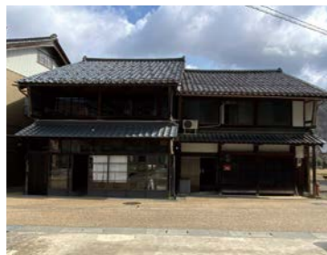
街道沿いに建つ、隣り合った二軒の民家(リノベ前)。正面右の建物を宿に、左の建物をカフェにリノベーション。
