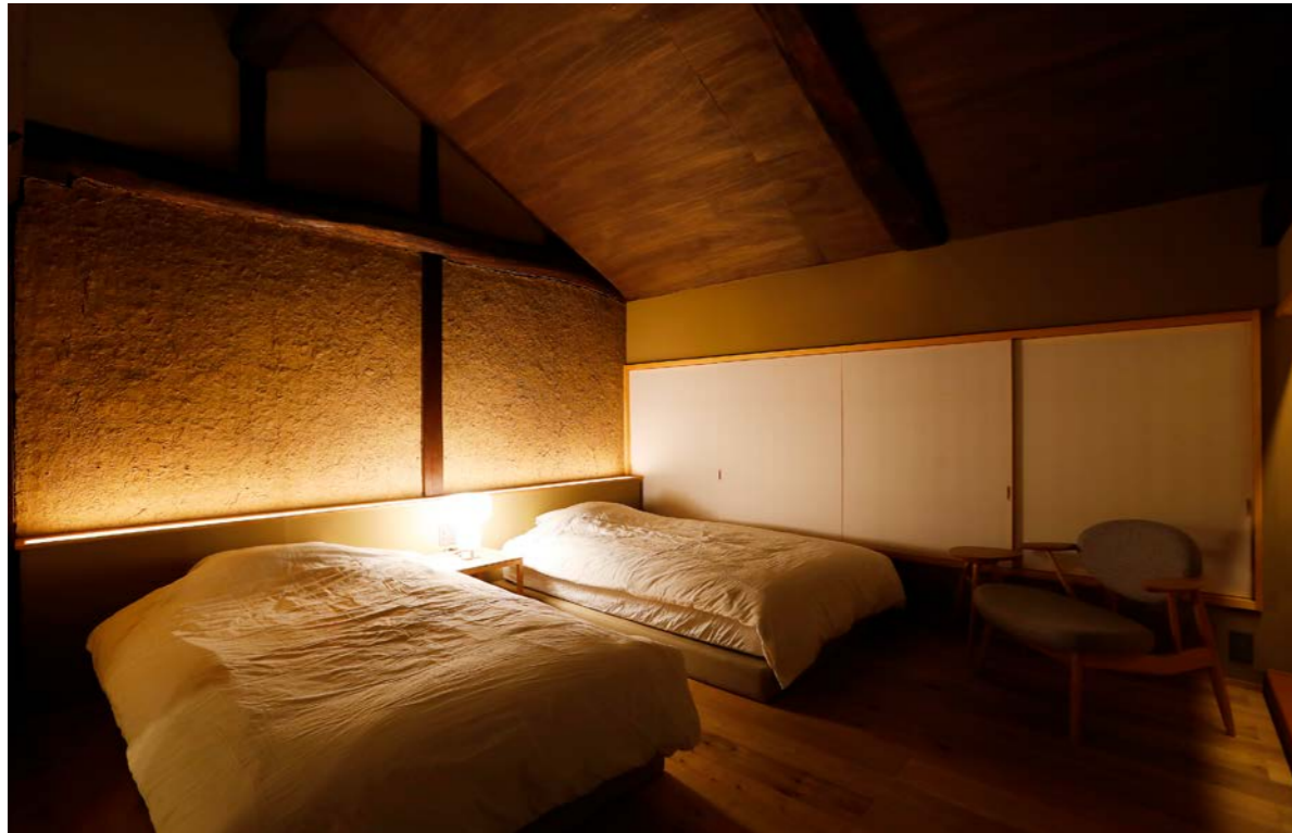
リノベ前の建物は土壁で無断熱の状態だったため、屋外に面する壁は高性能断熱パネルを使用して改修を行ったが、上の写真のような間仕切壁は昔ながらの土壁を残し、時が止まったかのような風情のある空間を再生し蘇らせている。
