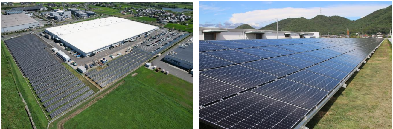
（写真）スーパーウォールの生産工場である熊山工場に自家消費型太陽光発電設備を設置
