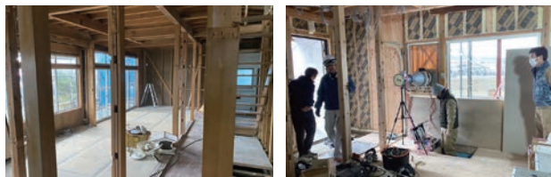
構造躯体は活かして耐震性を強化。気密測定を実施し、再生後の住宅性能も確認。
