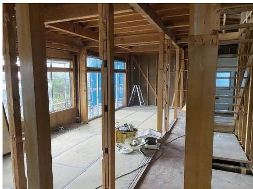
構造躯体は活かして耐震性を強化。気密測定を実施し、再生後の住宅性能も確認。
