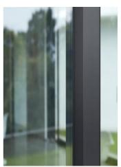
ダスクグレー色は、2022年より LIXIL が新たに展開する薄暮の時間帯をコンセプトにしたごくわずかに 青みを感じる低彩度のカラーで、住宅に美しく馴染みます。形材のトップ層に高耐候型アクリル塗料を適 用したテクスガードを採用することで、高い耐候性と耐食性で長期に渡り美しい風合いを維持します。
