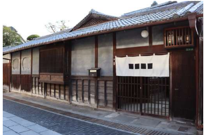
SAMURAI HOUSE -安芸竹原邸- 外観
