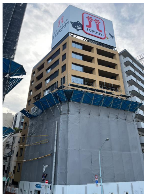
▲外観写真（2024年7月27日撮影）
