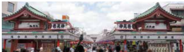
屋根改修前の仲見世
