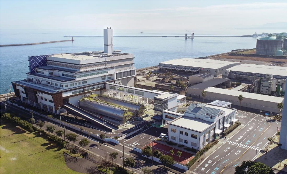
写真：鹿児島市南部清掃工場の外観（鹿児島市提供）
