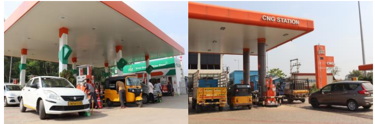
インドで展開するCNGステーション
