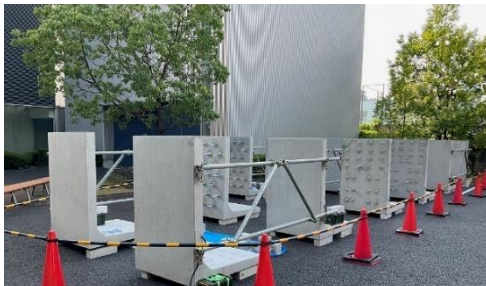
コンクリートの性能評価実験の様子 （代表事業者：清水建設）
