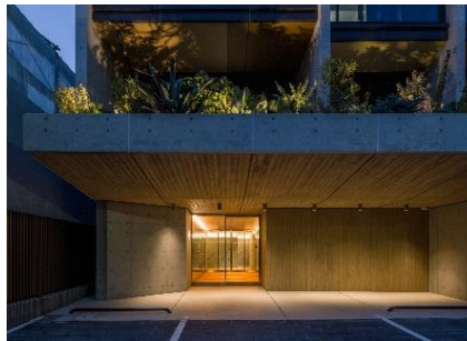
▲エントランス（外側）
