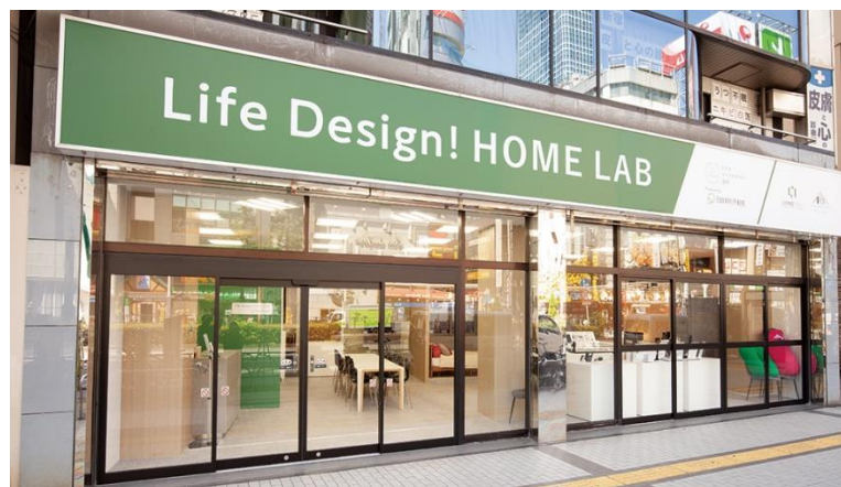
▲施設外観写真
