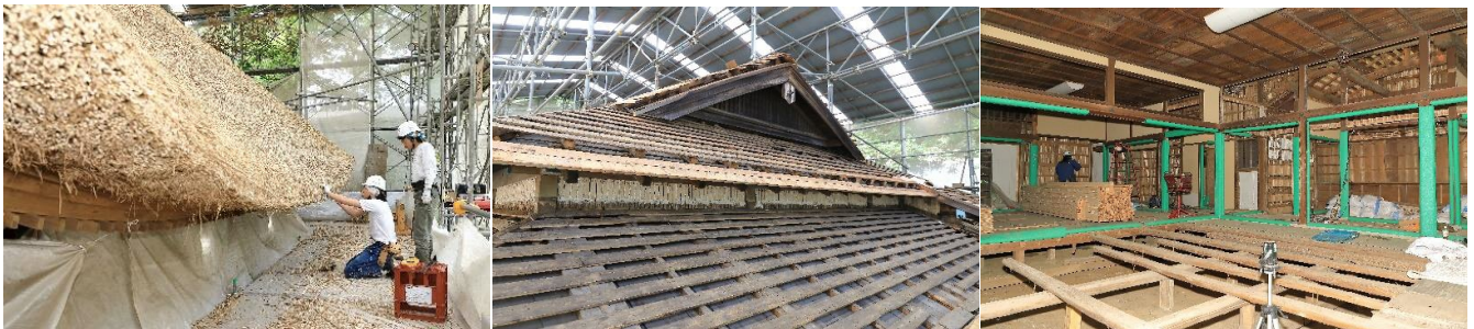
旧東慶寺仏殿 屋根葺き替え工事
