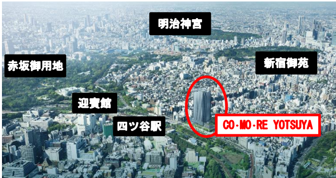
▲周辺エリア俯瞰写真
