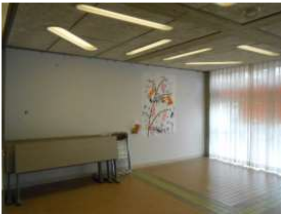
<改修前多目的室>
