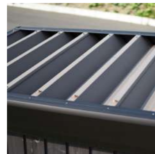
折半屋根 ガルバリウム鋼板
