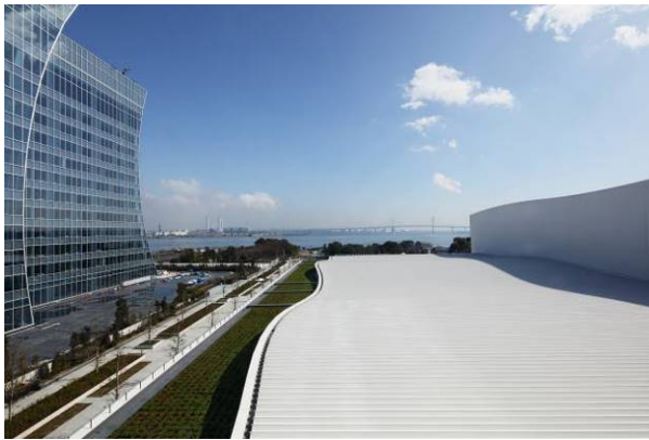
屋上緑化と汀（みぎわ）のように波打つ屋根
